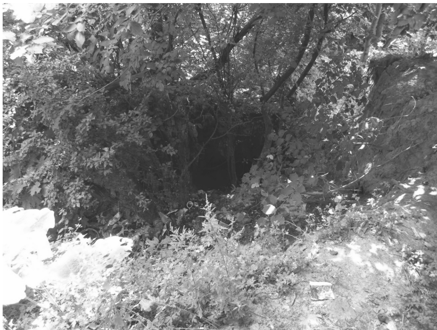
Рис. 3.11. Образование суффозионного провала на месте свалки опада листьев (г. Брянск). Фото С.Н. Ковалева
